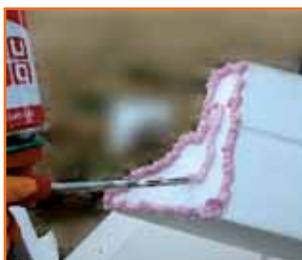
Зазоры между деталями необходимо оставлять от 2 до 5 мм. Для склеивания деталей между собой рекомендуется использовать полиуретановый клей (**Ceresit CT 84, PENOSIL Fix&Go Montage или TYTAN Styro 753**).
