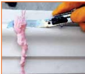
Макетным ножом срежьте излишки высохшего клея и в месте соединения справа и слева под углом сделайте фаску глубиной от 2 до 5 мм. Заполните канал с помощью эластичной шпатлёвки CMC Izolasyon. После высыхания шпатлёвки стыки нужно отшлифовать.
