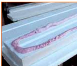
Обратную сторону элемента нужно обработать с помощью гребенки клеевым со-ставом **Ceresit (CT 83 или CT 85)** либо другим аналогичным составом.
