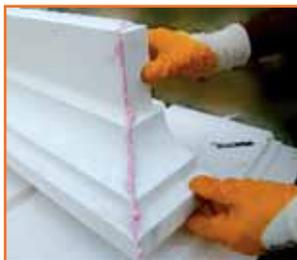
После заполнения стыков полиуретановым клеем дальнейшую обработку необходимо проводить только после полного высыхания. Дополнительно стыки можно проклеить малярной сеткой.
